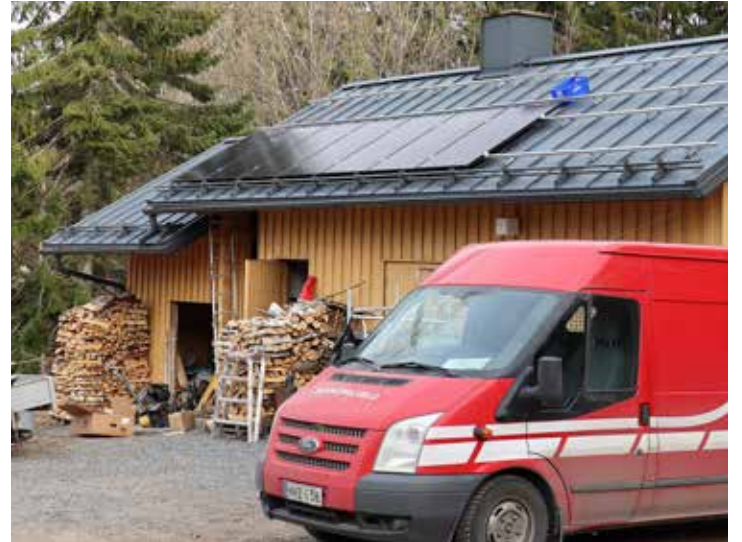
Aurinkopaneelien myötä talo siirtyi ekologisempaan energiankäyttöön.
